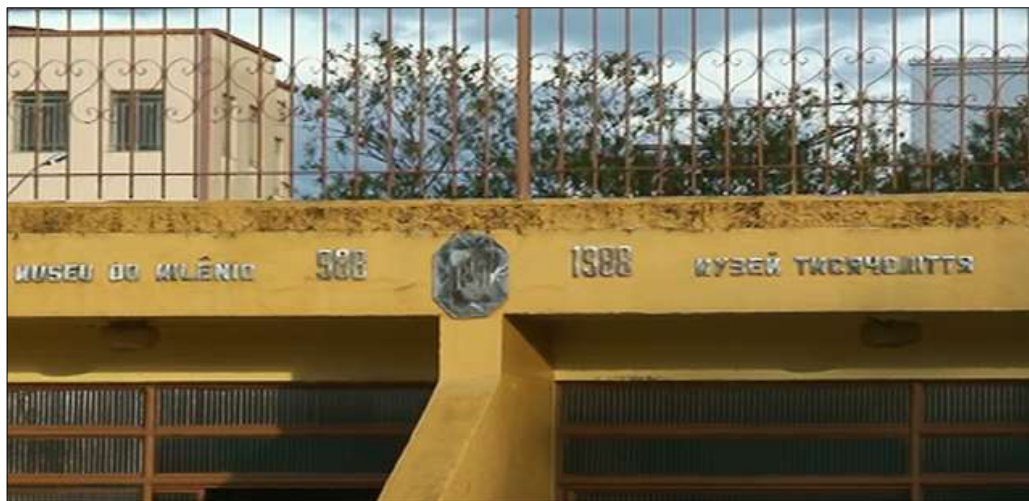
Figura 6 – Fachada do Museu
