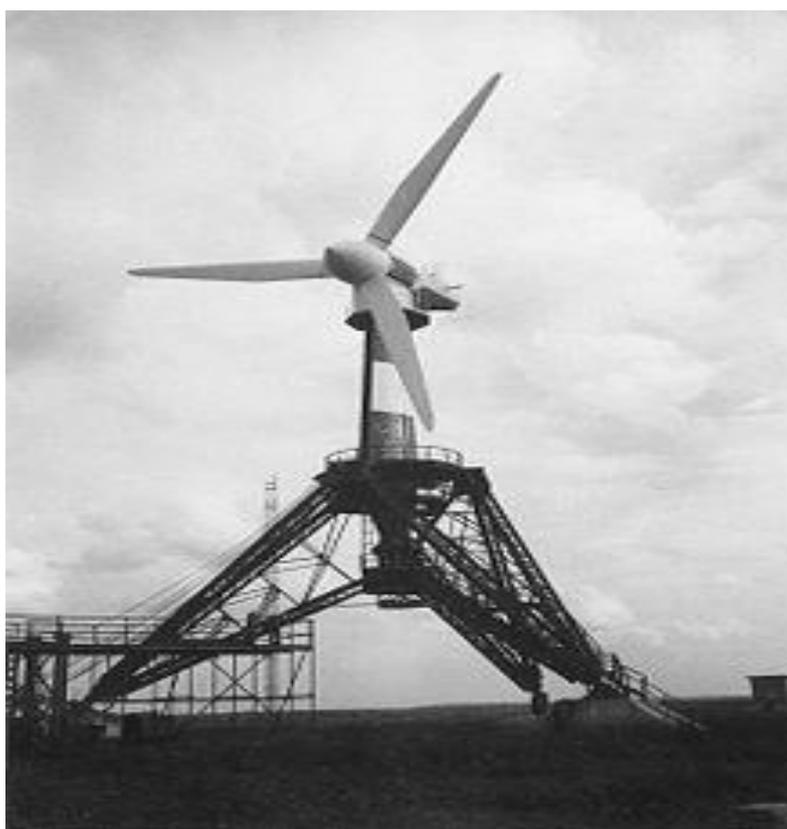
Figura 03: Modelo de aerogerador utilizado na Rússia (1931).<sup>7</sup>
